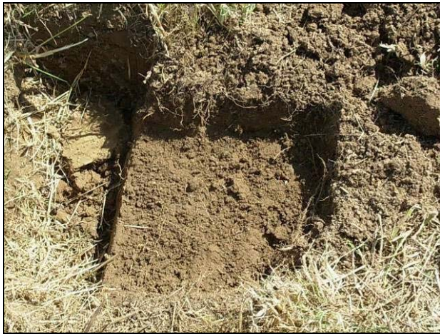
Décapage de ma surface sur une épaisseur de 4 cm
